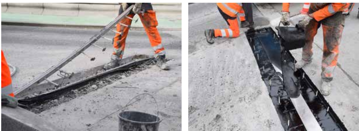
Démontage et réfection d'un joint de chaussée (entretien spécialisé)
