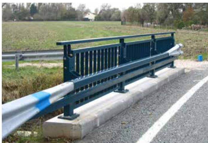
Garde-corps double fonction assurant également la retenue des véhicules légers
