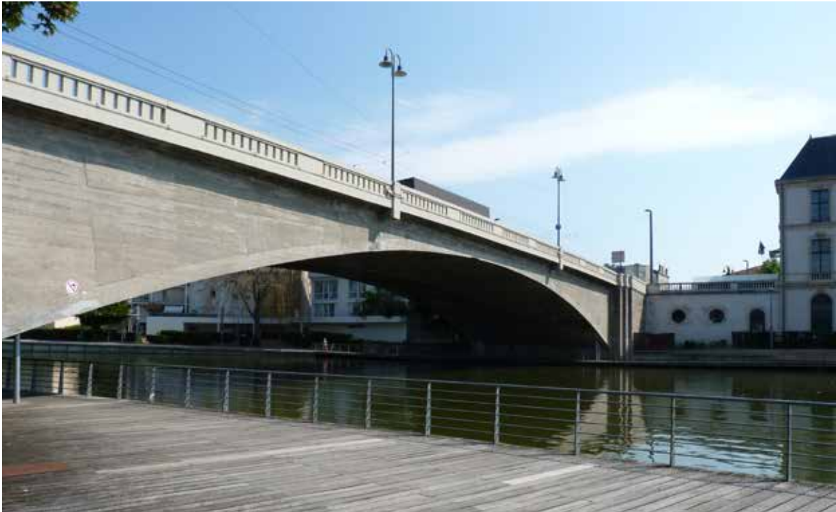
Pont d'Essey sur la Meurthe (1948). Métropole du Grand-Nancy Les ponts, passerelles et leurs abords contribuent fortement à la qualité de l'espace public.
