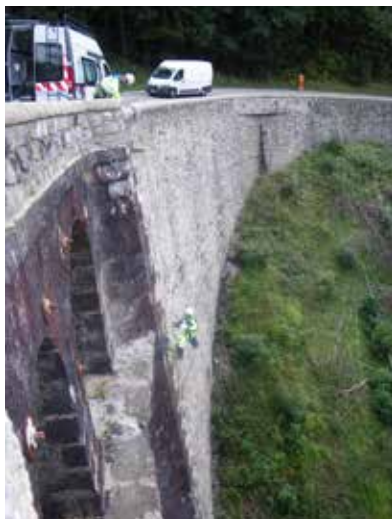
Ici dévers trop important dans le virage pour le déploiement d'une nacelle négative
