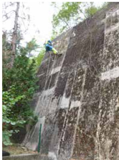
Zones d'influence supérieure et en contrebas du mur, non accessibles au moyen d'une nacelle
