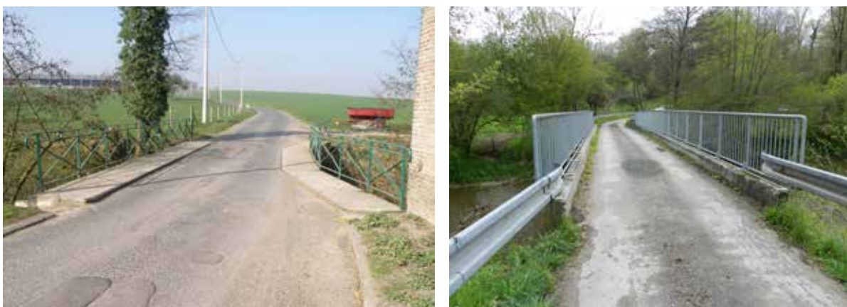
Abords d'un ouvrage
