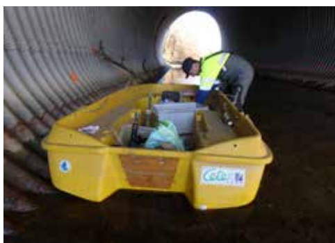
Visite d'ouvrage en site aquatique au moyen d'une barque, voire d'un bateau à moteur
