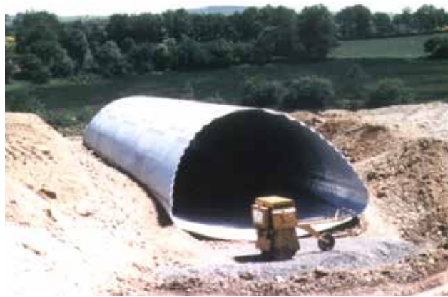
Buse métallique en service, buse en construction
