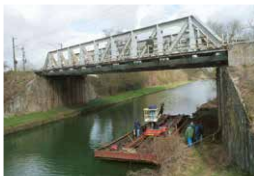
Visite d'ouvrage en site aquatique au moyen d'une nacelle positive installée sur une barge
